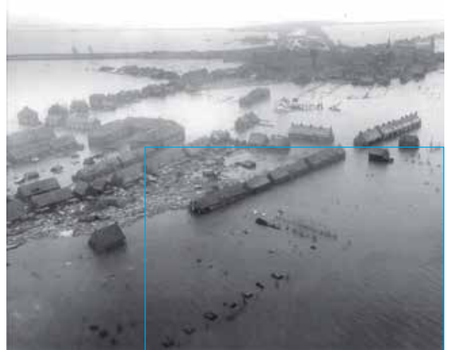
En 1953, une tempête en Mer du Nord fait monter le niveau de l'eau de plusieurs mètres dans l'estuaire de l'Escaut. Aux Pays-Bas, les digues cèdent, mal entretenues depuis le début de la guerre 40-45. Près de 50 000 habitations seront inondées.
